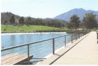
A railing is being installed. (X) 난간이 설치되고 있다.
